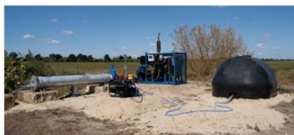
Комплекс робіт із запуску насосної станції
