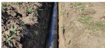
Земельні роботи, укладання магістральних трубопроводів
