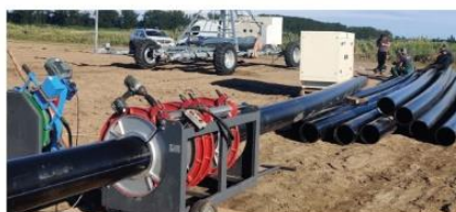
Зварювання пластикових трубопроводів
